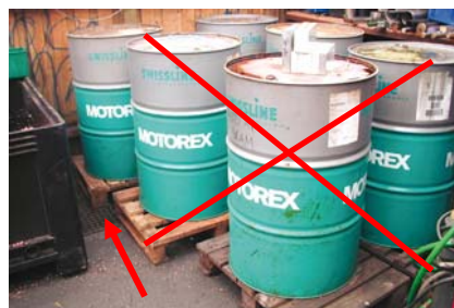
Undgå opbevaring af farligt affald og råvarer ved eller oven på afløb til kloak
